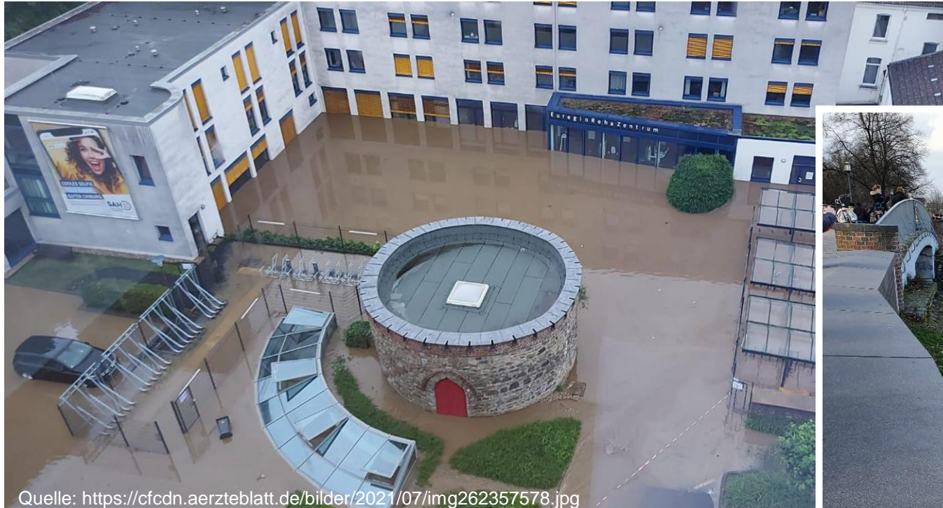
St.-Antonius-Hospital in Eschweiler (NRW, Hochwasserkatastrophe Juni 2021)
